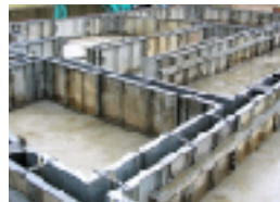
型枠組立て完了
