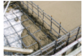
ベースコンクリート打設
