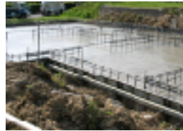
ベースコンクリート打設完了
